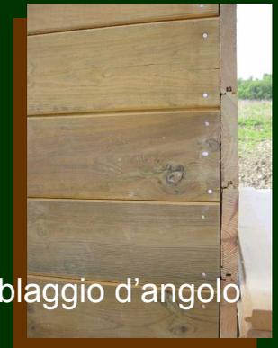
Dettaglio assemblaggio d'angolo
